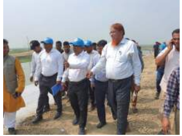
৫ মার্চ ২০২৩, সুনামগঞ্জ জেলায় ডুবন্ত বাঁধ নির্মাণের চলমান কাজ পরিদর্শন
